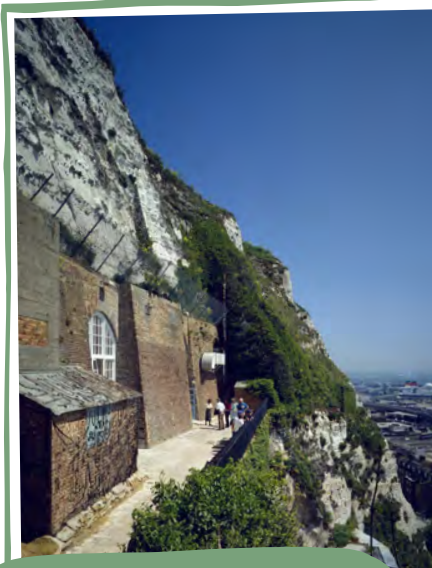
Les anciens tunnels constituaient un lieu parfait pour le quartier général naval : ils étaient protégés des bombardements, avaient vue sur le port et étaient situés à proximité du PWSS.
